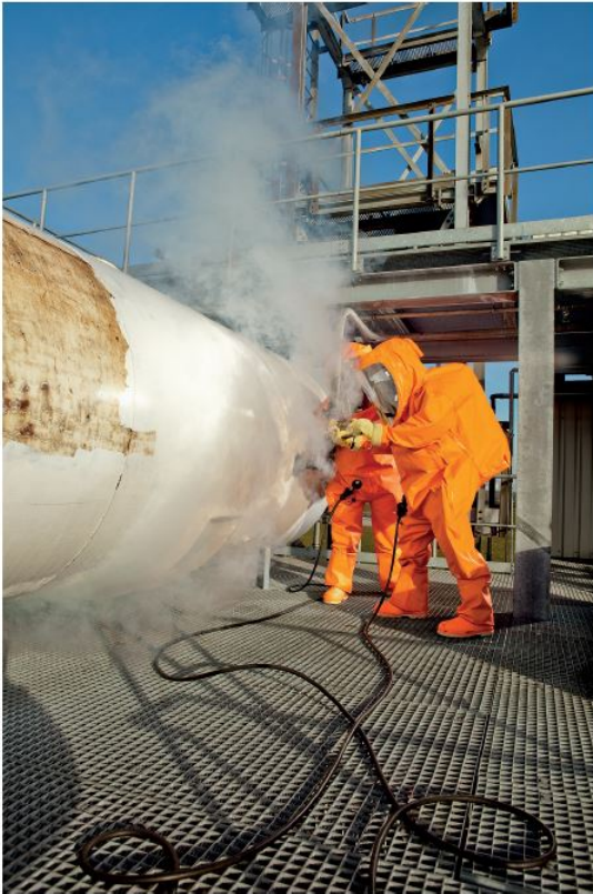
Figuur 2.4: Werkzaamheden in gaspak met een meerurenaansluiting; onafhankelijke adembescherming.
